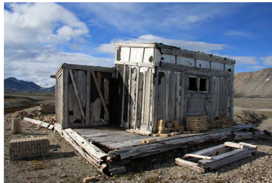
IMG 9078—fasadehjørnet øst - nord.
