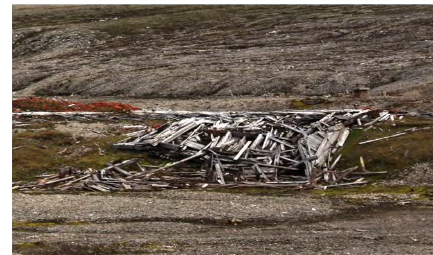
Fundamentet med diverse restene av huset.
