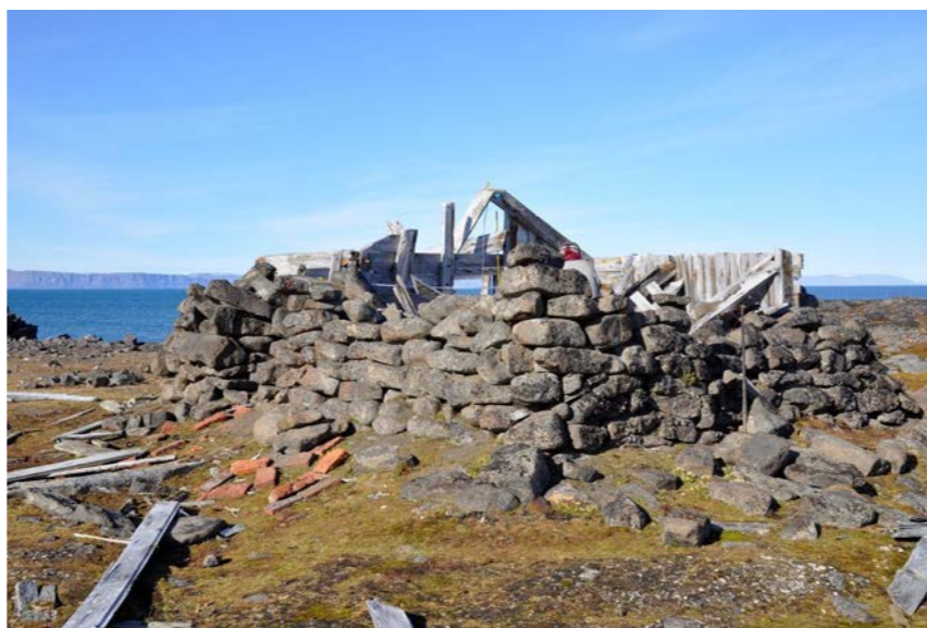
Bilde DSC 0005. Inngangsbyggingen av tre er helt forsvunnen.
