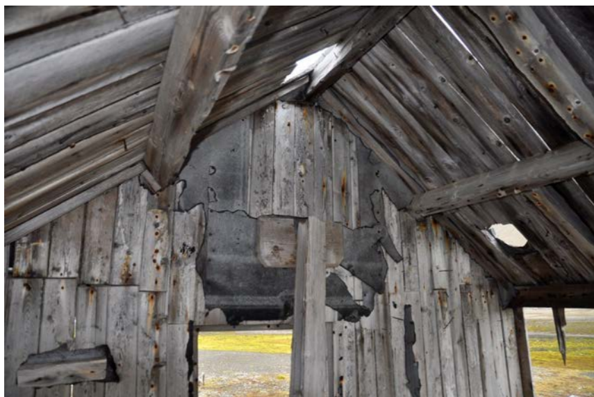
DSC 0463: Hytten innvendig, sett mot fasade A
