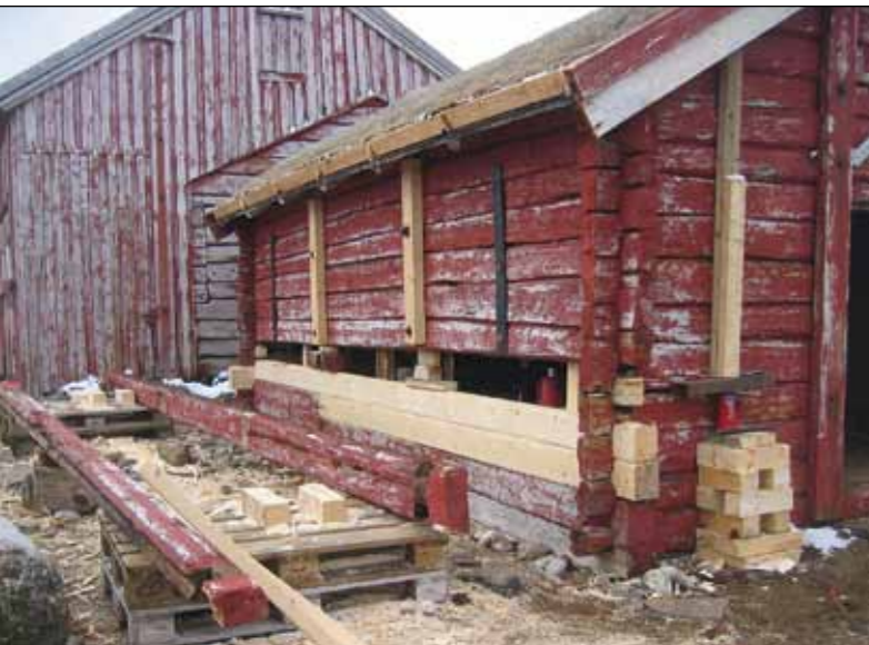
Hammerfesthytta på Bjørnøya er den eldste, stående norske fangsthytta på Svalbard. Sysselmannen har brukt store ressurser på vedlikehold og istandsetting. Her fra arbeidet i 2010.
