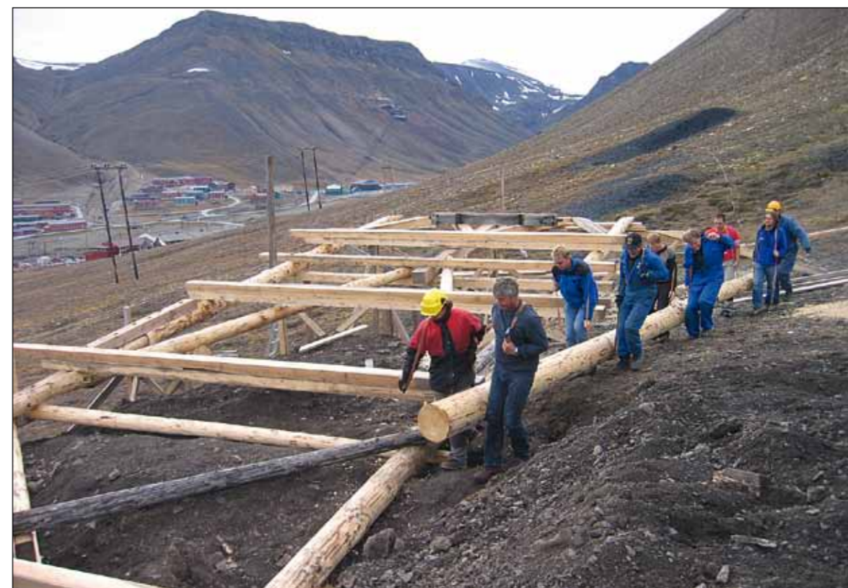
Sysselmans sterke menn på tømmerbæring. Fire hovedstokker og midtstilt boks bæres til rett posisjon på bukkens andre hoveddel. Rekonstruksjon av nedrast taubanebukk (nr. 23), taubanelinje 1b, Longyearbyen.
