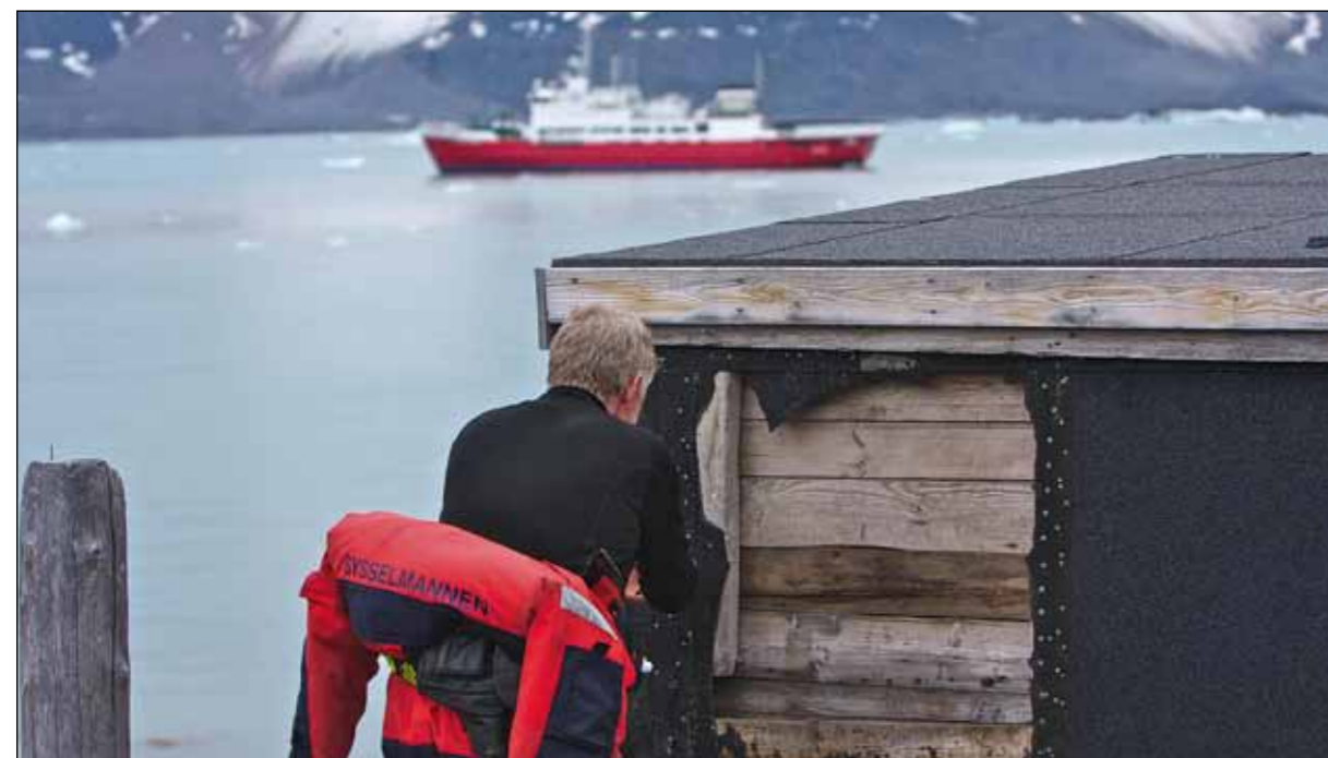
Reparasjon av skader er en ganske vanlig oppgave for Sysselmannens ansatte i felt. Her fra tetting av veggpapp på Texas Bar etter at isbjørnen hadde skadet den. Hytta har vært lånt ut til forskere og er en av hyttene som årlig lånes ut til lokalbefolkningen i påskea etter trekning.
