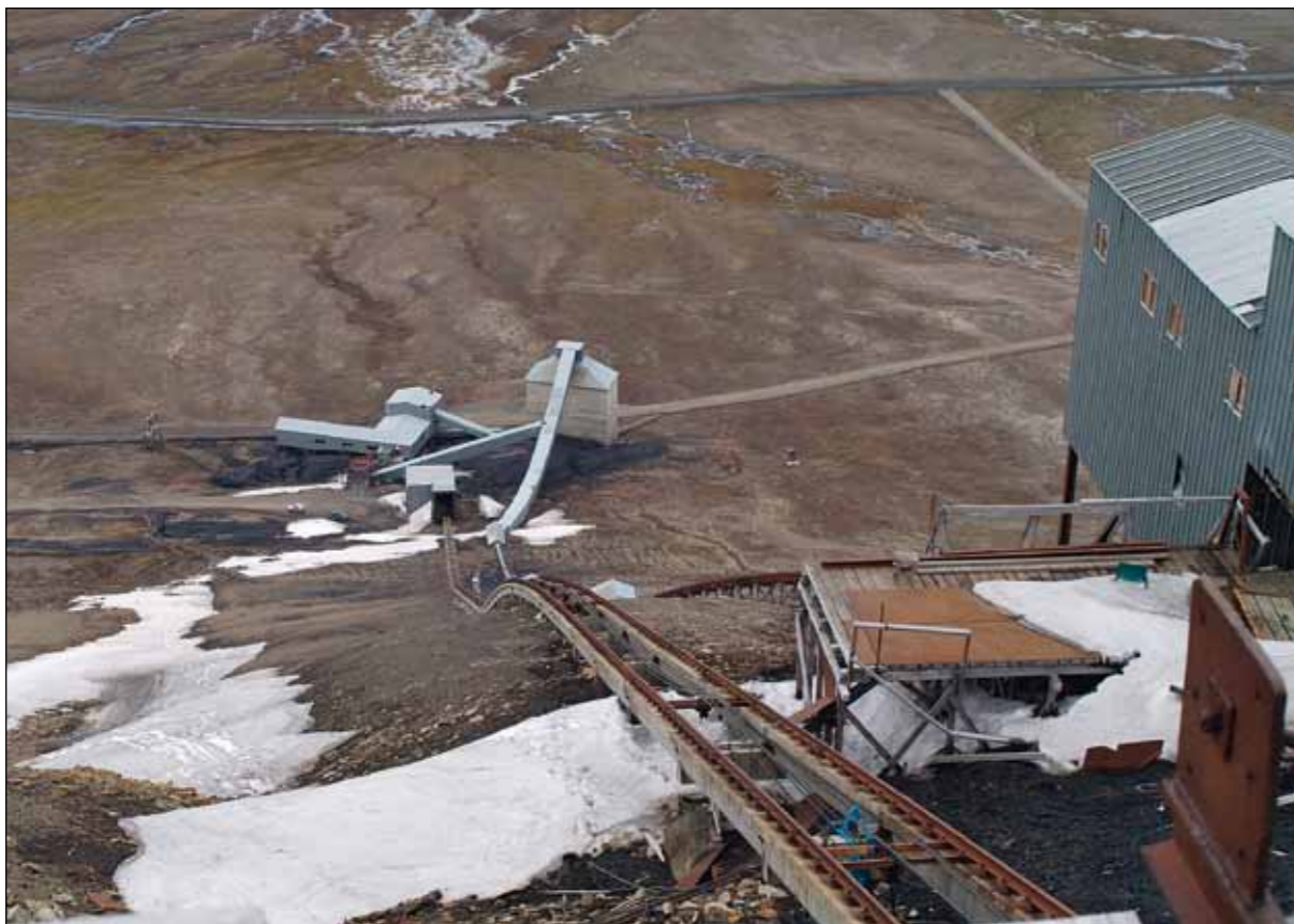
Gruve 6 i Longyearbyen har høy nasjonal verneverdi. Det er i plan fra 2010 foreslått å frede de øvre delene av daganlegget (den nedre delen er vedtaksfredet som en del av taubaneanlegget).
