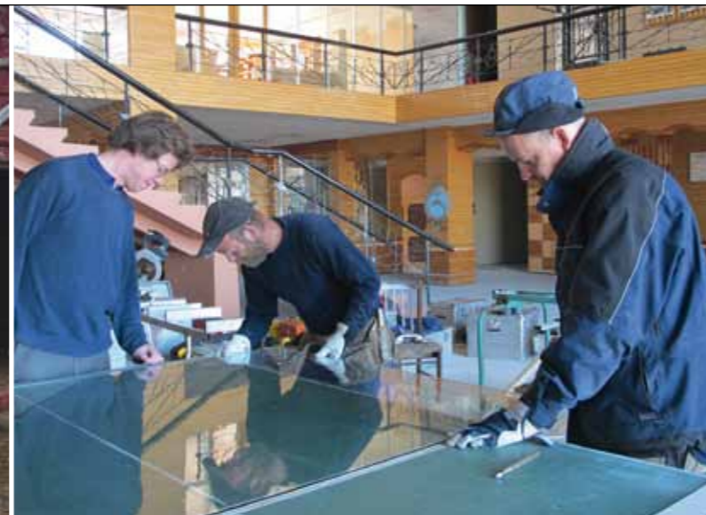
I 2011 og 2012 samarbeidet russiske/ukrainske og norske håndverkere om istandsetting av flere av bygningene i Pyramiden. Her skjæres glass til vinduer inne i kulturhuset.
