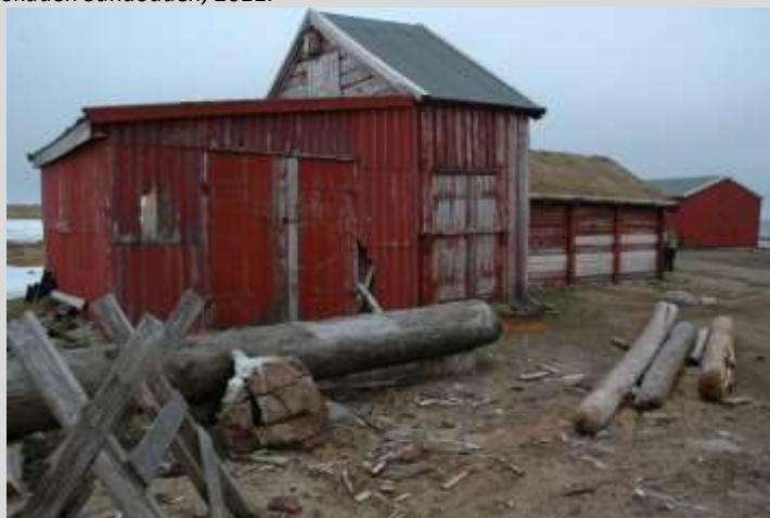
Figur 183 Bygg nummer to fra høyre er Hammerfesthuset, til venstre for dette er restene av Tobiesenhuset, mens tilbygget lengst til venstre er et nyere skur. Foto: Irene Skauen Sandodden, 2011..
