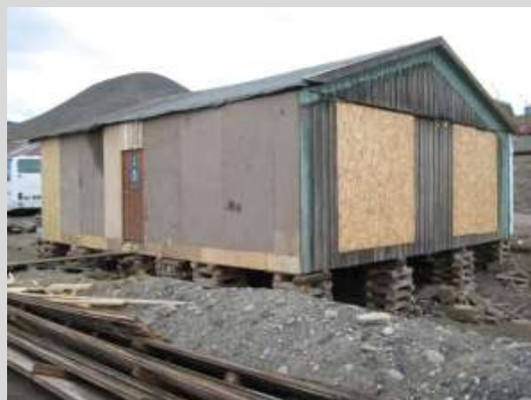
Figur 123 Transporten under istandsetting. Ett av de få automatisk fredete bygningene i Longyearbyen. Foto: Siri Hoem 2007.
