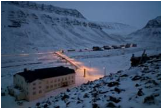
Figur 14 Huset har en sentral plass i livet i Longyearbyen, til tross for sin perifere plassering i dag. Bygningen har høy verneverdi og eksteriøret er regulert til kulturminneområde i arealplan for Longyearbyen I bakgrunnen sees Nybyen. Foto: Lars Erik Alfheim, 2013 (privat).
