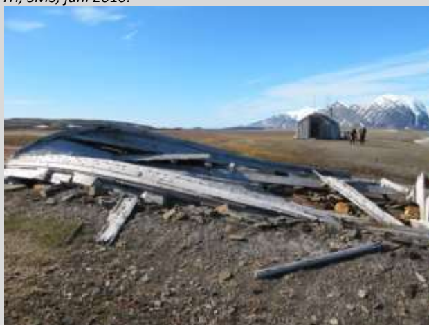
Figur 63 Båten/jordkjelleren "Kjeftausa" er i dårlig forfatning. Foto: Hilde Tokle Yri, SMS, juni 2010.
