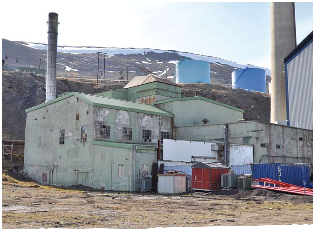
Den gamle kraftstasjonen.
