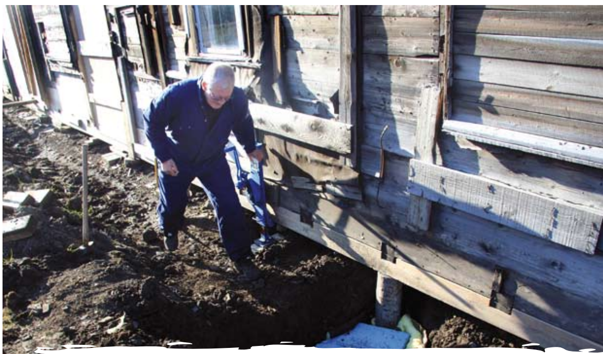
Løft: Syssele mannen på Svalbards håndverker Karl Fredheim jekker og pæler Boligbrakke C på Hiorthhamn.
