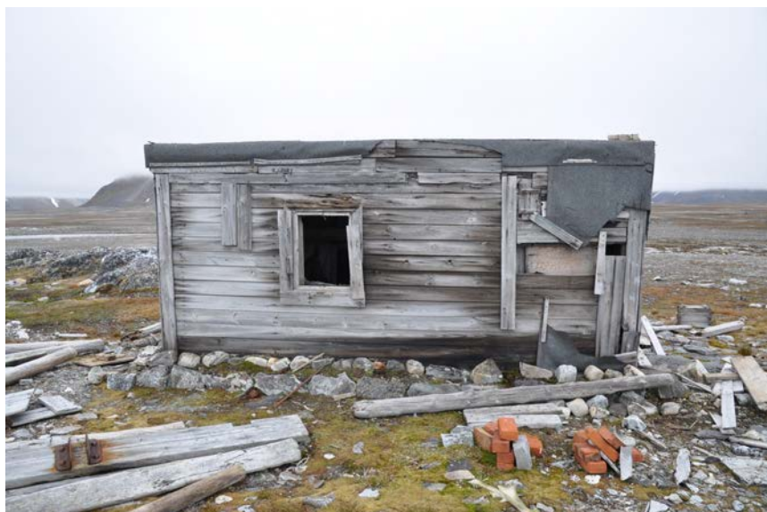
Fasade D, bilde DSC 0161
