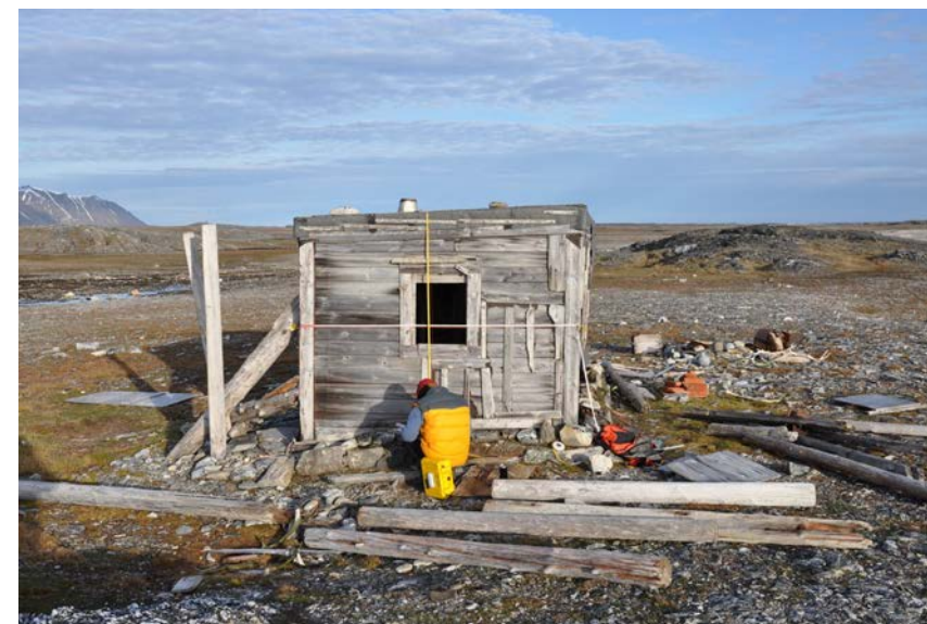
Oppmålingsarbeidet i gang ved fasade C –Bilde DSC 154
